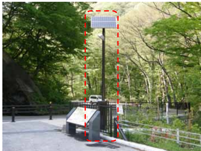
群馬県安中市・めがね橋観光駐車場
